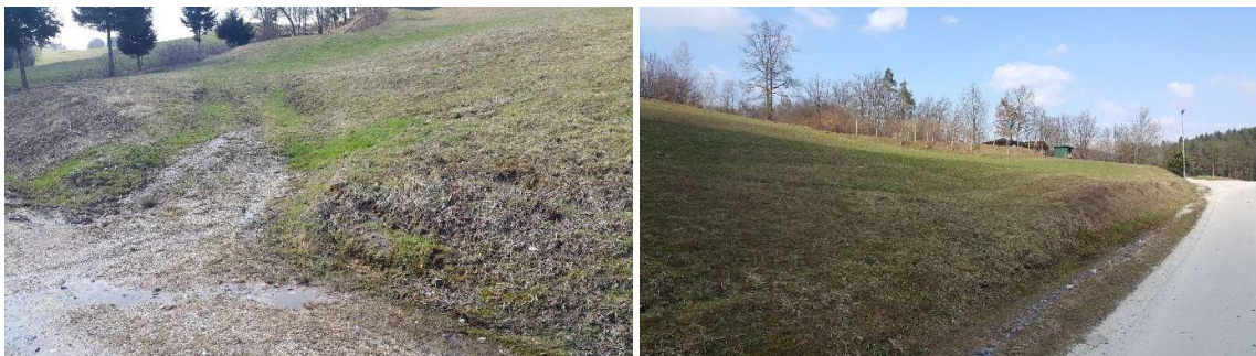
FOTO 1,2: izviri vode v useku ceste, kot je s programom Surfer prognozirano
